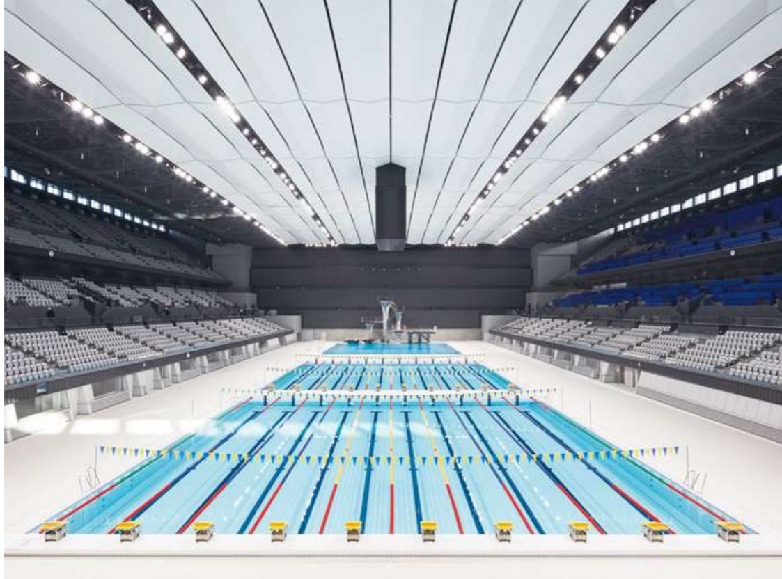
PROJECT REPORT 東京アクアティクスセンター
