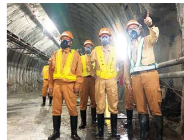
トンネル坑内での粉じん障害防止状況確認のためのパトロール
